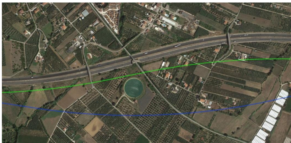
Impianto del Consorzio in bonifica in Destra del fiume Sele
