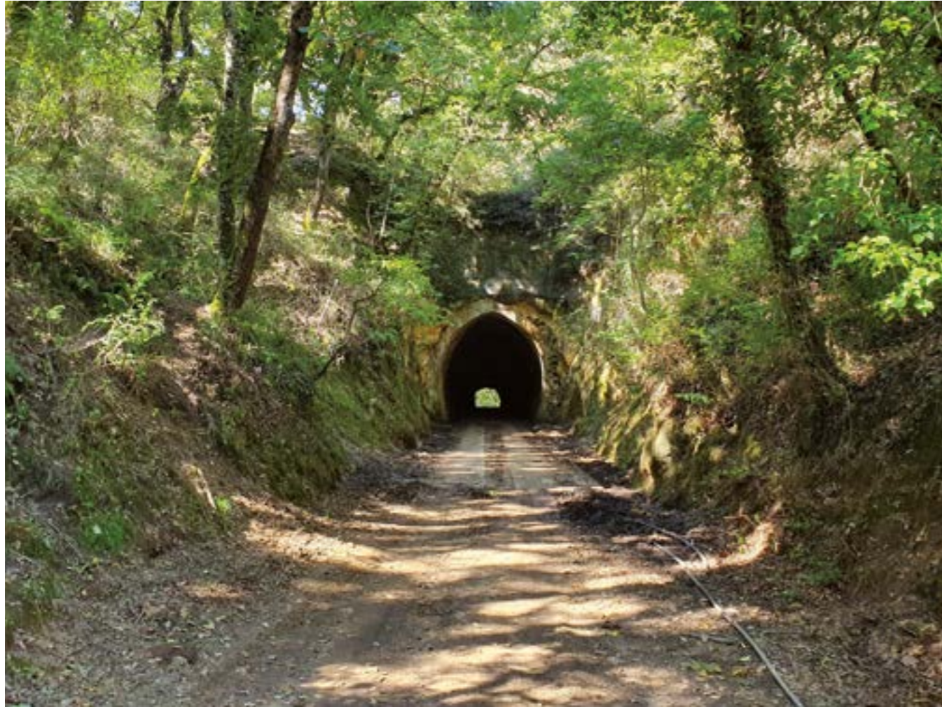
Galleria Portella di Cerro in località Ficuzza, Monreale (PA)
