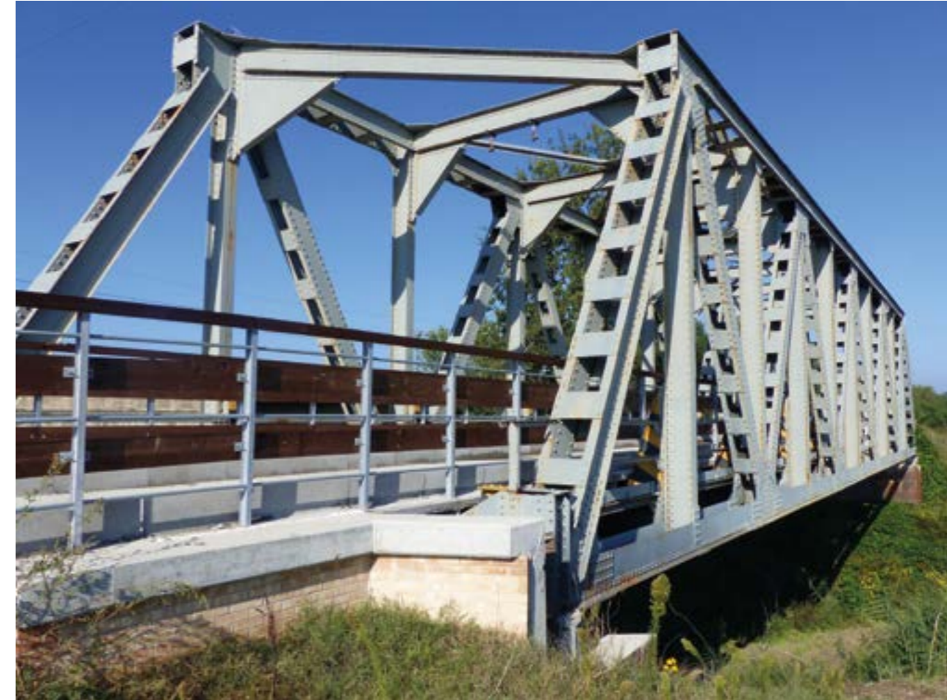
Ponte ristrutturato sul Torrente Lavino
