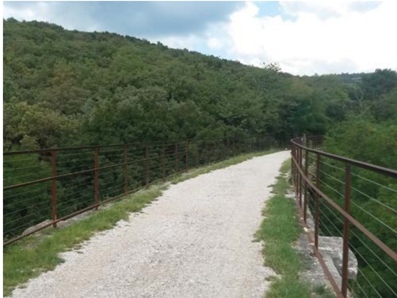
Viadotto Longera tra S. Anna di Trieste e S. Giuseppe della Chiusa (TS)
