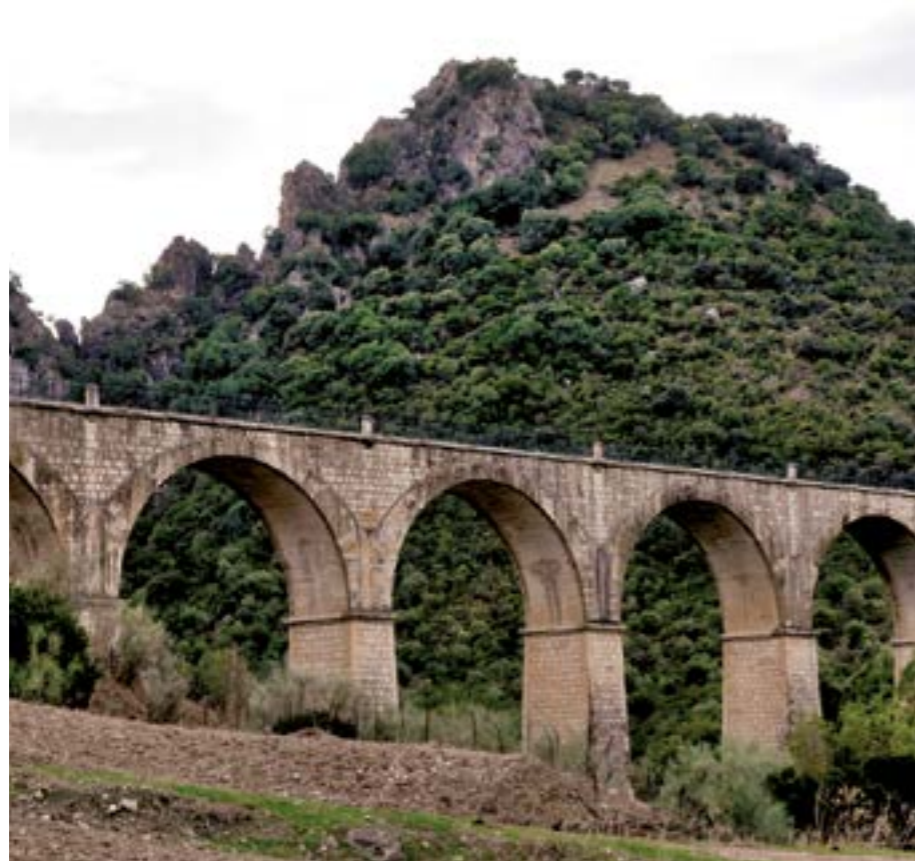
Viadotto di Zaframagón (Spagna)
