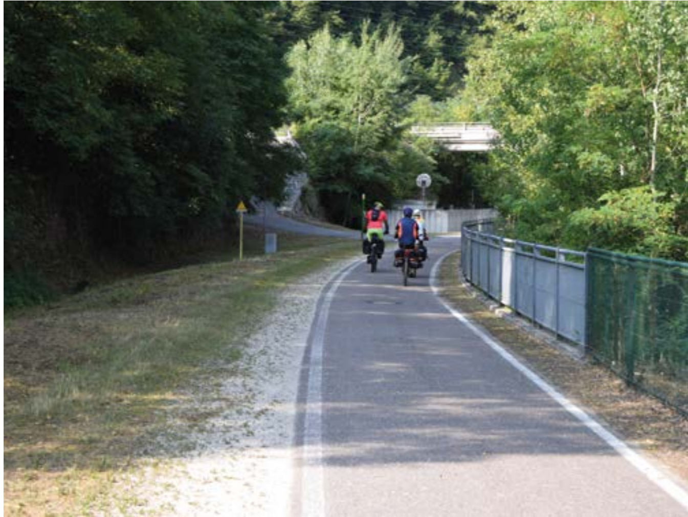
Tratto a sud della fermata di Fiè (BZ)
