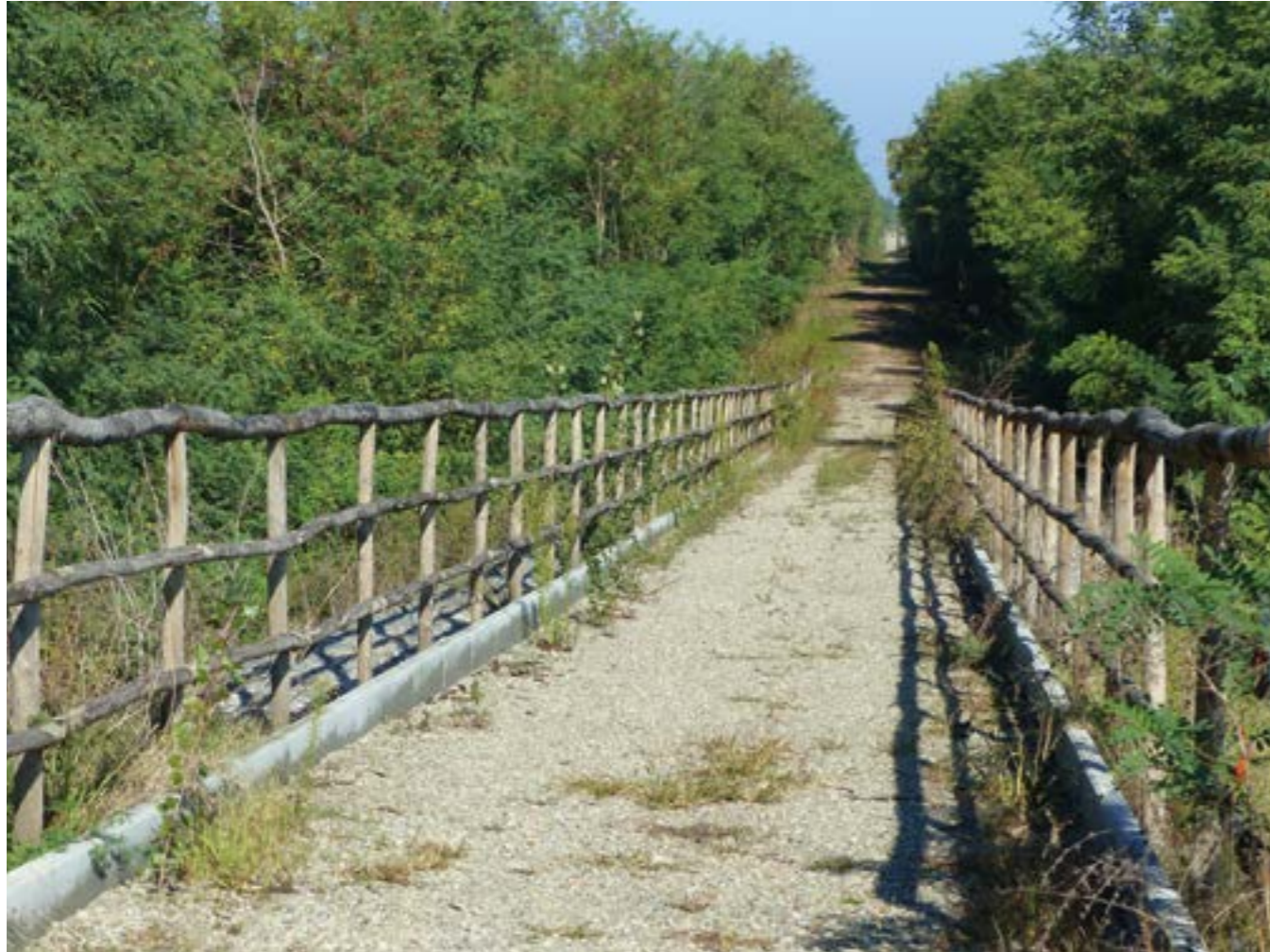
Greenway in realizzazione in località Osteria Nuova
