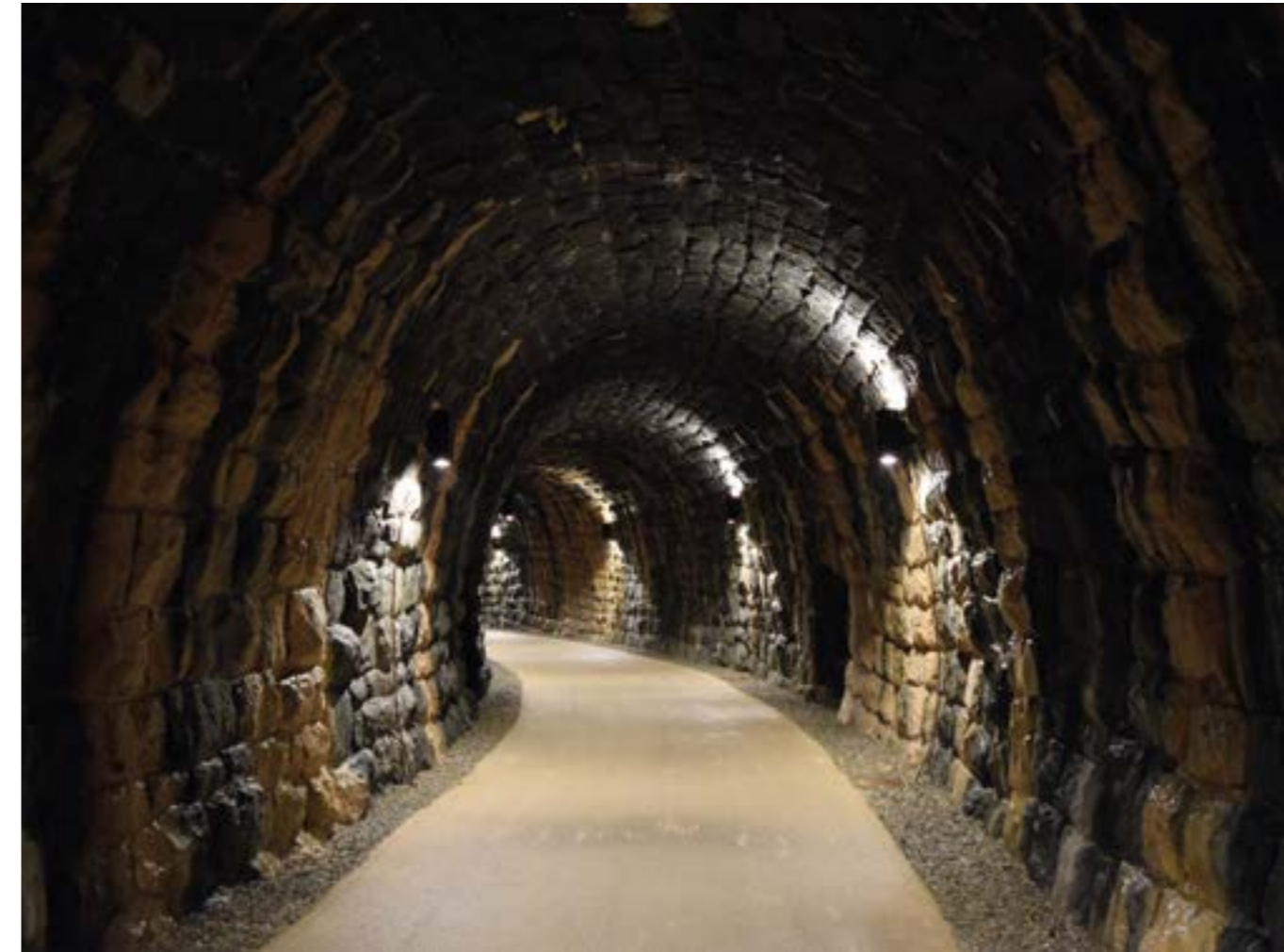
Tratto all'interno della galleria di Santa Cristina (BZ)
