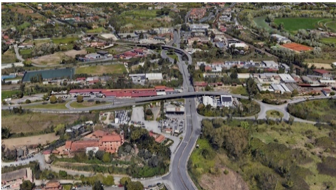
Figura 46: Vista aerea su via Flaminia Vecchia e via di Tor di Quinto, a sinistra Vigna Clara a destra Tor di Quinto – stato di fatto
