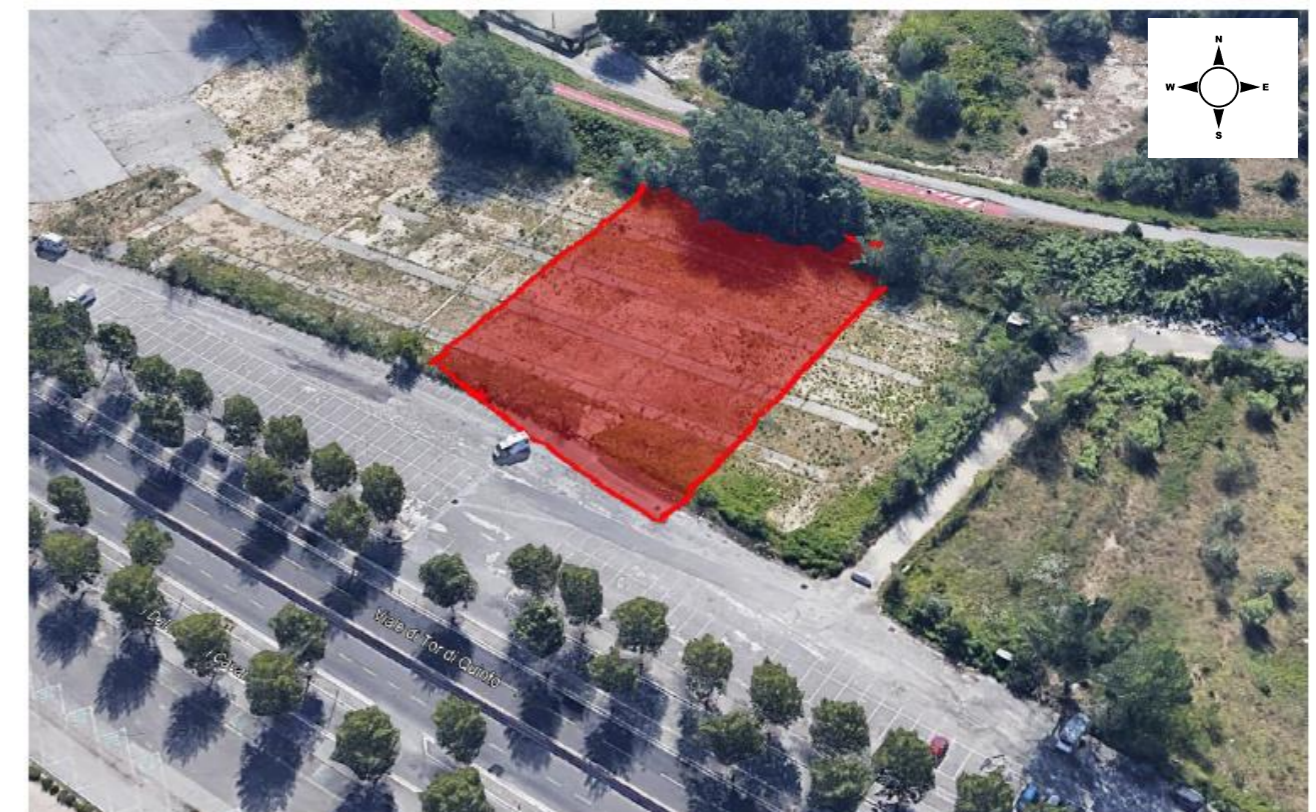
Figura 101: Cantiere Base CB1.01 - Ingresso da viale di Tor di Quinto
