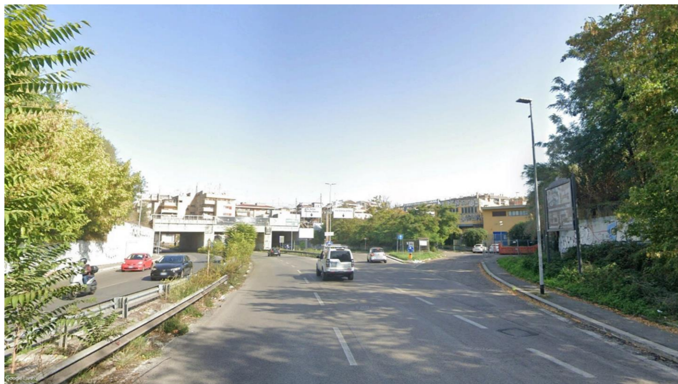
Figura 66: Vista da via dei Prati Fiscali in direzione via Salaria – stato di fatto
