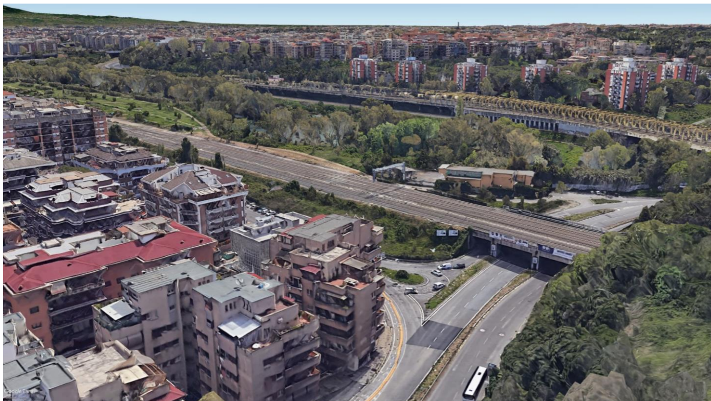
Figura 69: Vista dall'alto punto di scavalco via Prati Fiscali – stato di fatto
