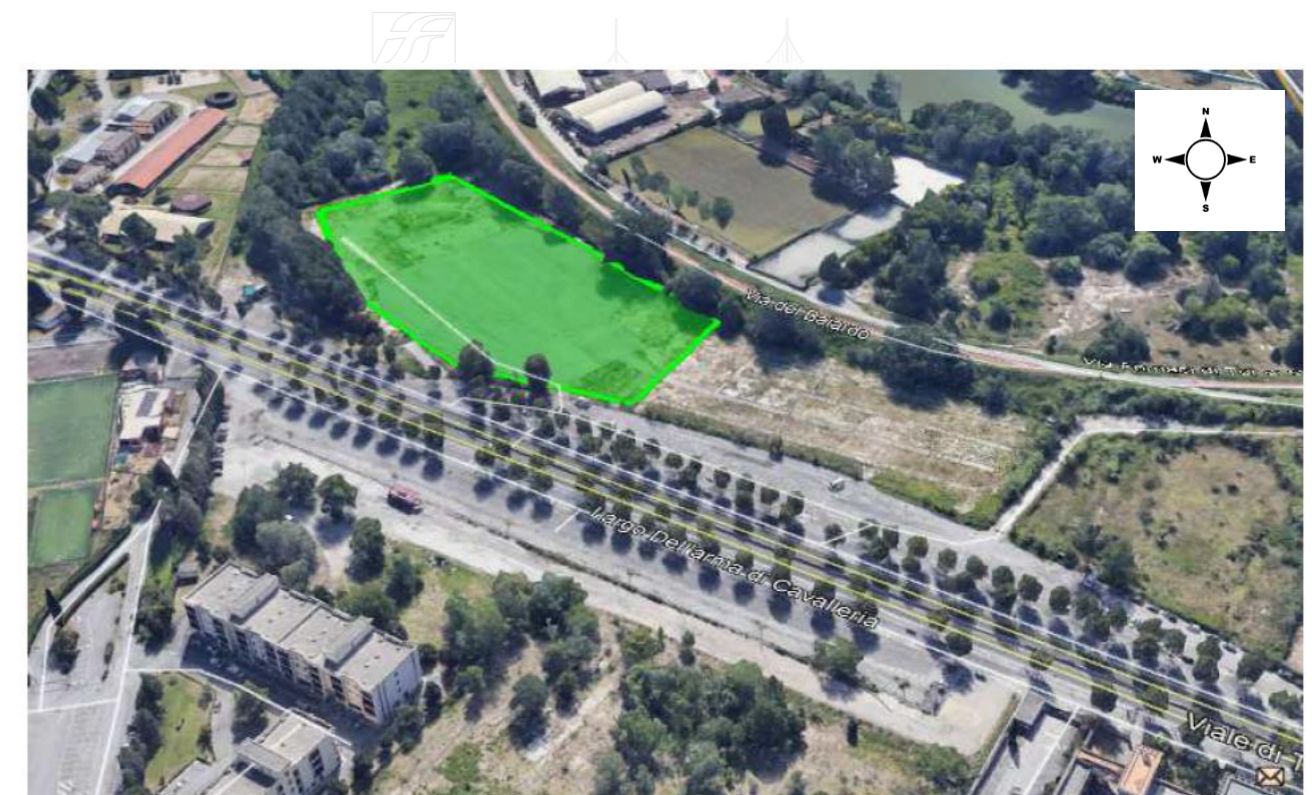
Figura 122: Cantiere Operativo CO2.01 - Ingresso da Viale di Tor di Quinto
