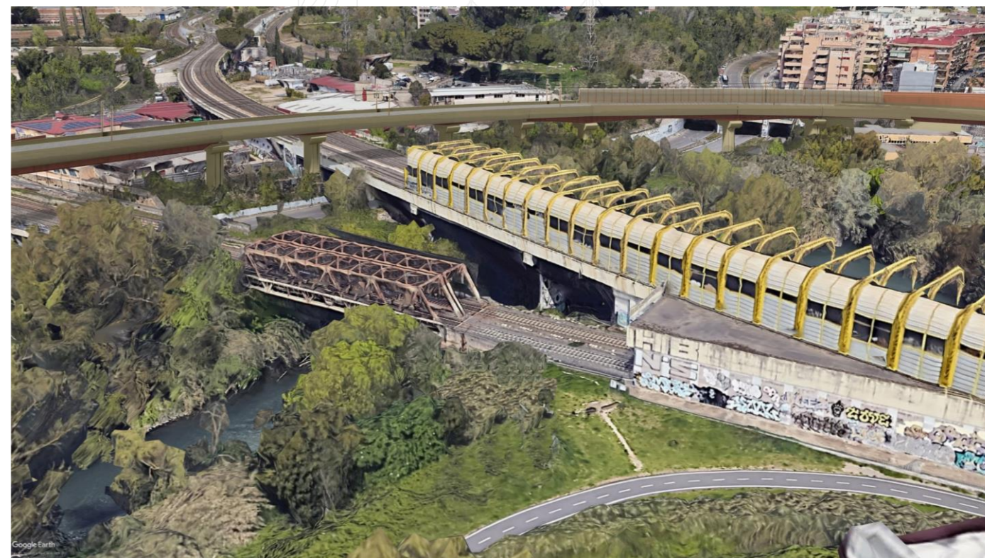
Figura 65: Zona di scavalco linea Direttissima, linea FL1, via dei Prati Fiscali, vista dall'alto - stato di progetto
