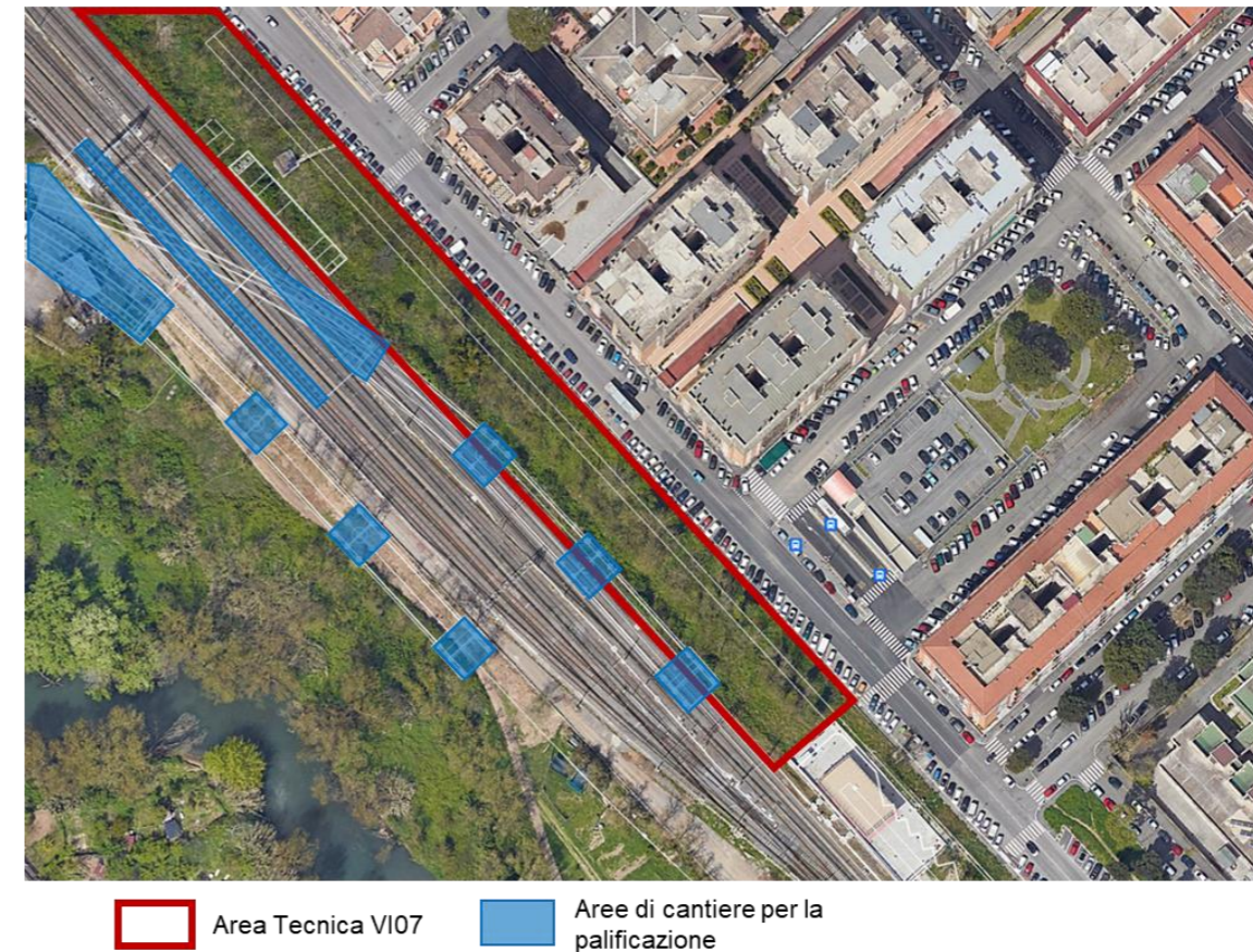
Figura 139: Localizzazione dell'area tecnica VI07
