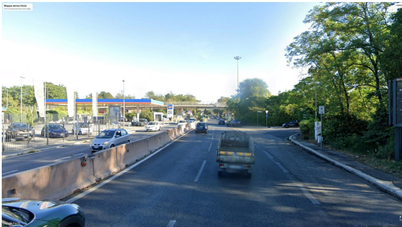
Figura 50: Vile di Tor di Quinto, vista da strada – stato di fatto
