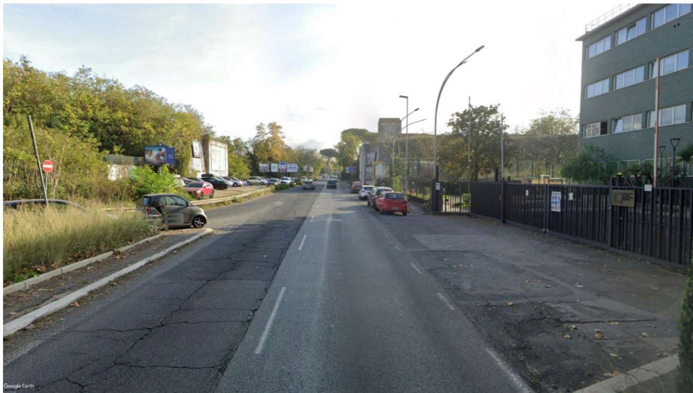
Figura 62: Via Salaria, vista da strada- stato di fatto
