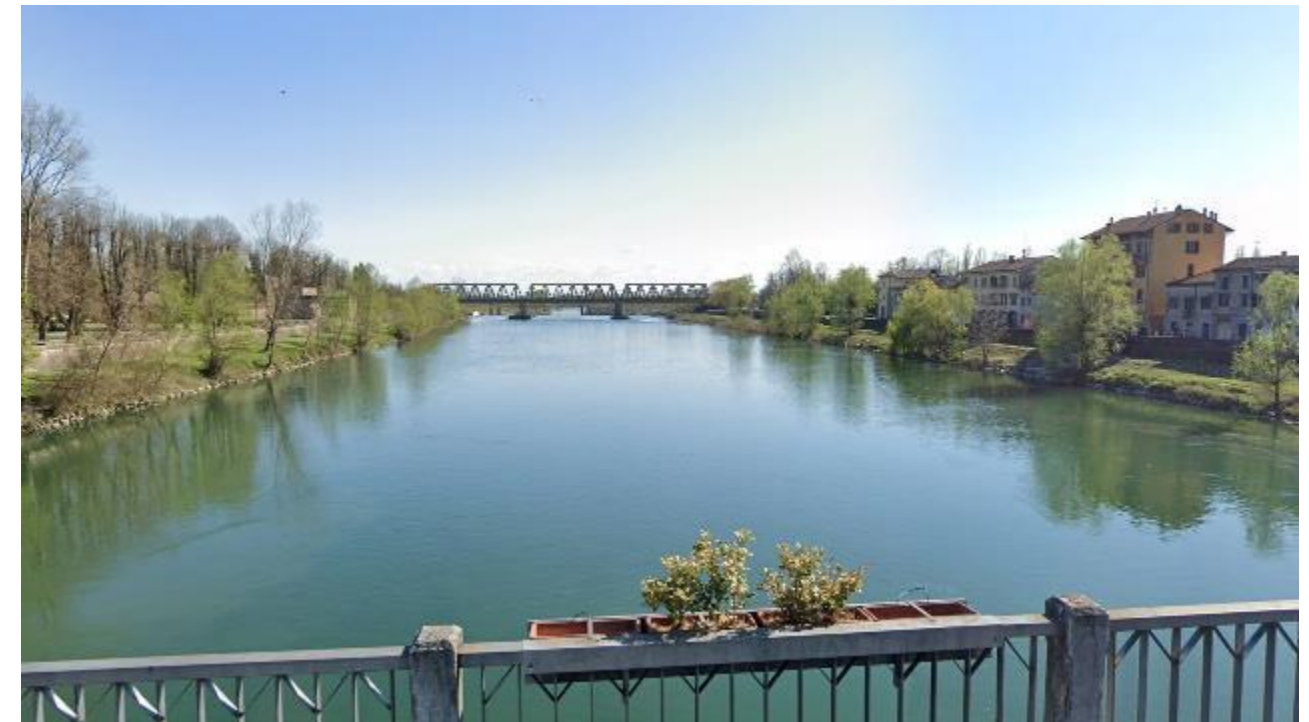
Figura 3-28 - Viadotto sul Fiume Adda (VI01). Condizioni percettive post operam
