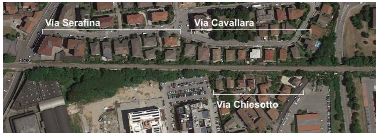
Figura 3-46- Lotto 2: Ambito Cremona - Fronte edilizio in corrispondenza dell'asse Via Serafina – Via Cavallara e Via Chiesotto
