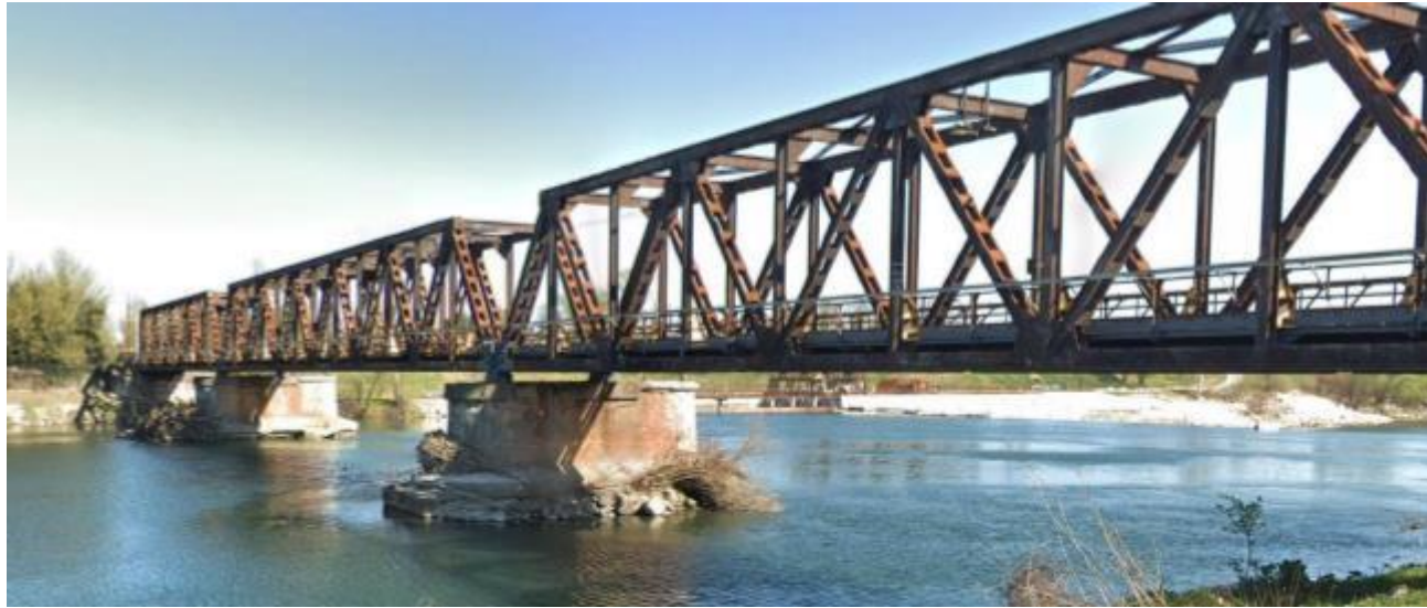
Figura 3-14 - Ponte ferroviario esistente sul Fiume Adda a Pizzighettone: vista di monte da Codogno verso Cavatigozzi
