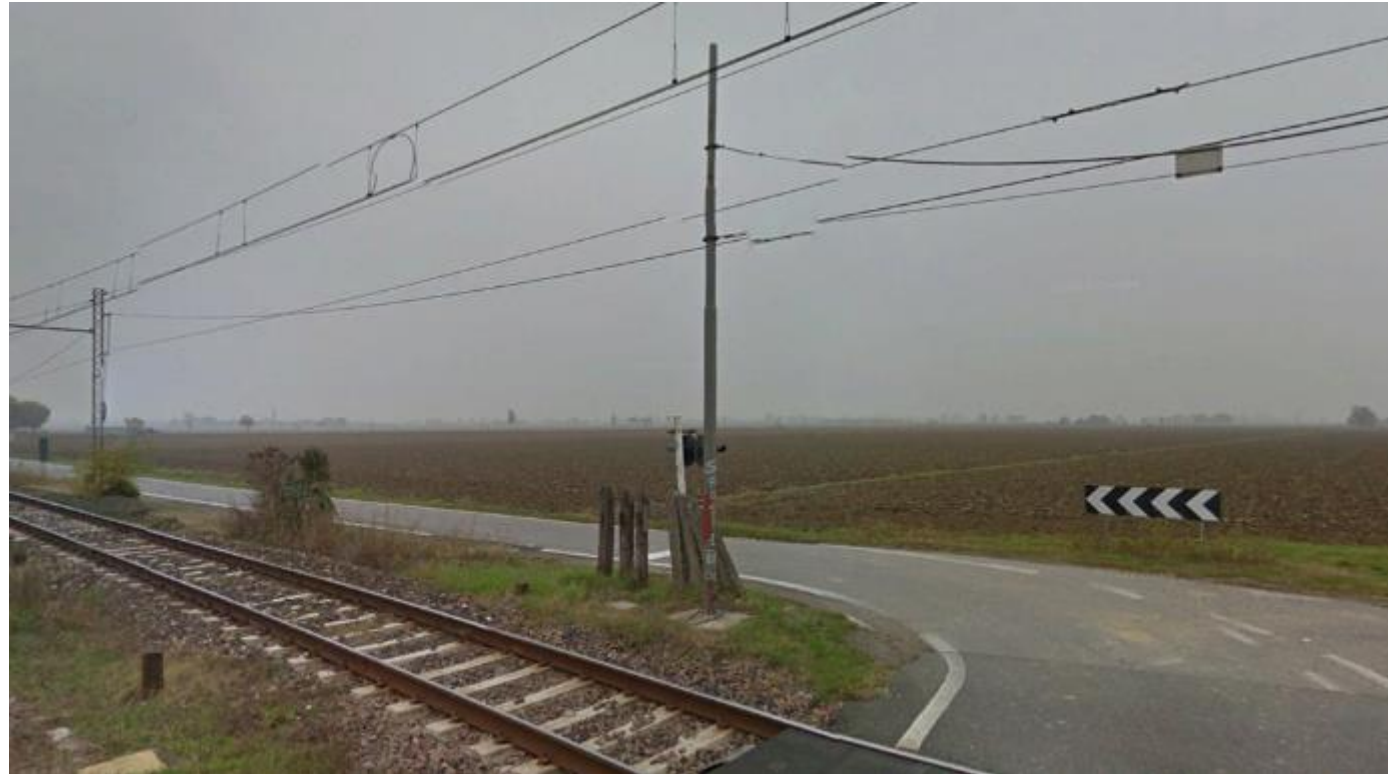
Figura 3-22 - Contesto agricolo in cui è inserita l'opera
