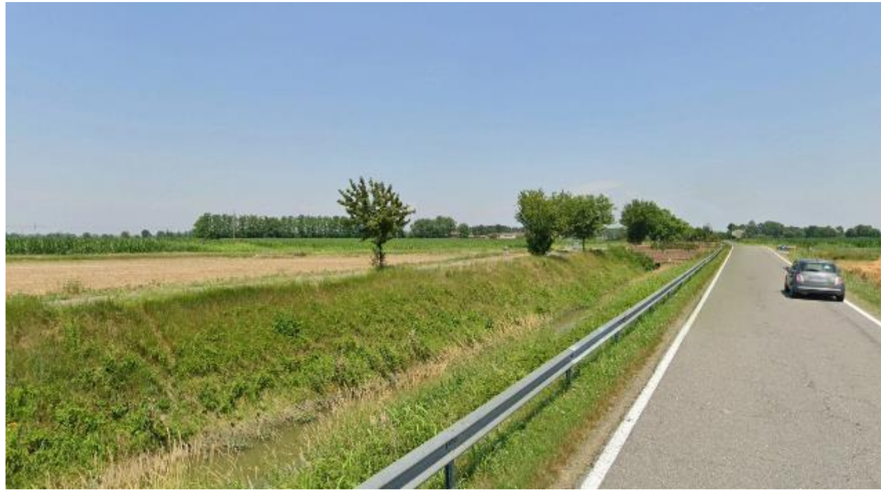
Figura 3-29- Condizioni percettive ante operam dalla SP27 in corrispondenza del Complesso Cascina Cà dé Marozzi
