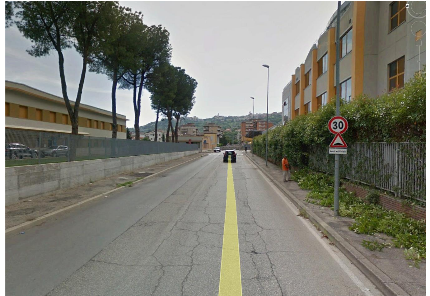
Figura 4-24 Via E. Mattei – Stato attuale
