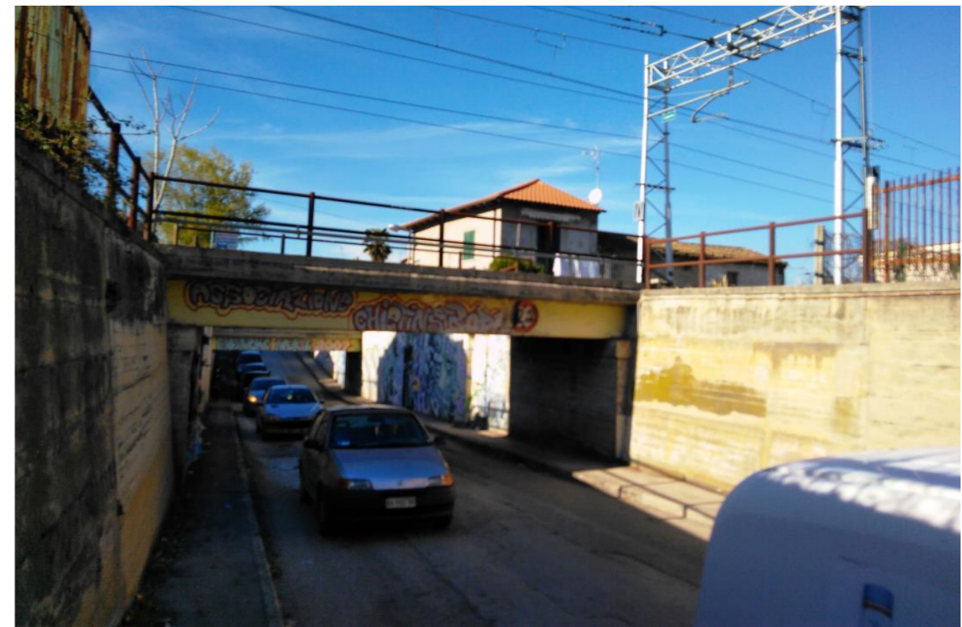
Figura 5-32 VI09 – Stato di fatto
