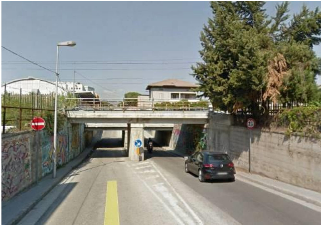
Figura 4-23 Via E. Mattei – Stato attuale
