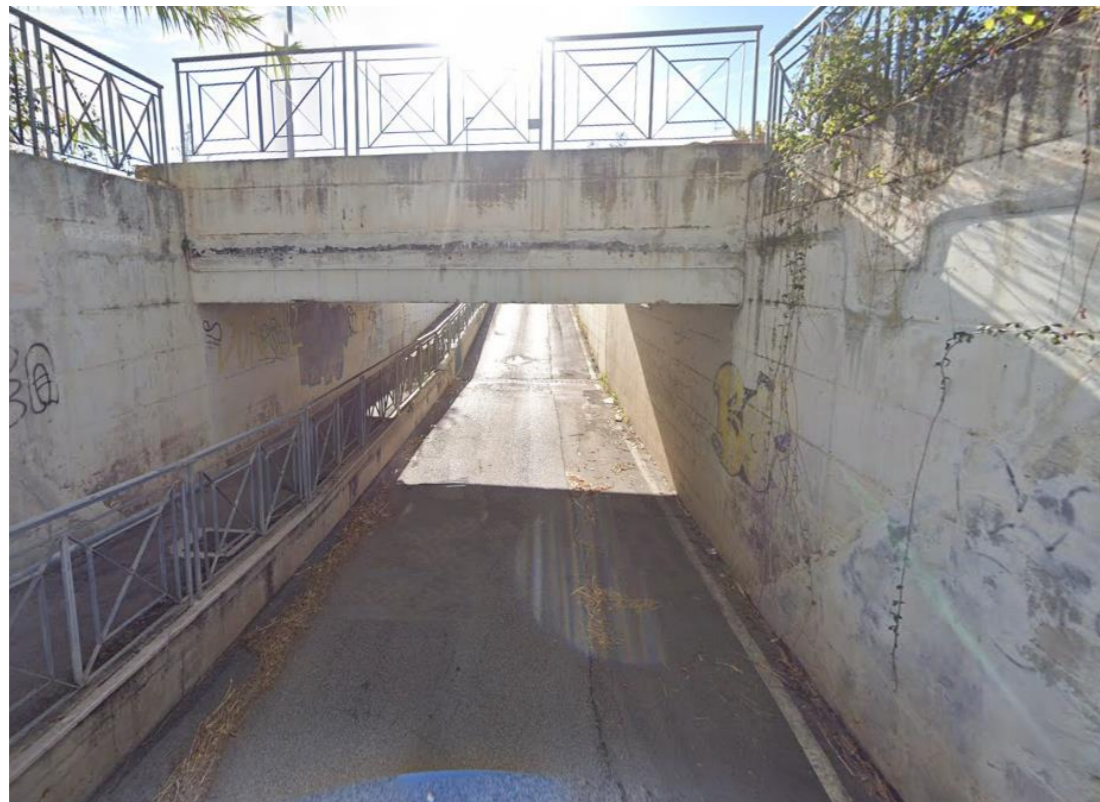
Figura 5-30 VI08 – Stato di fatto
