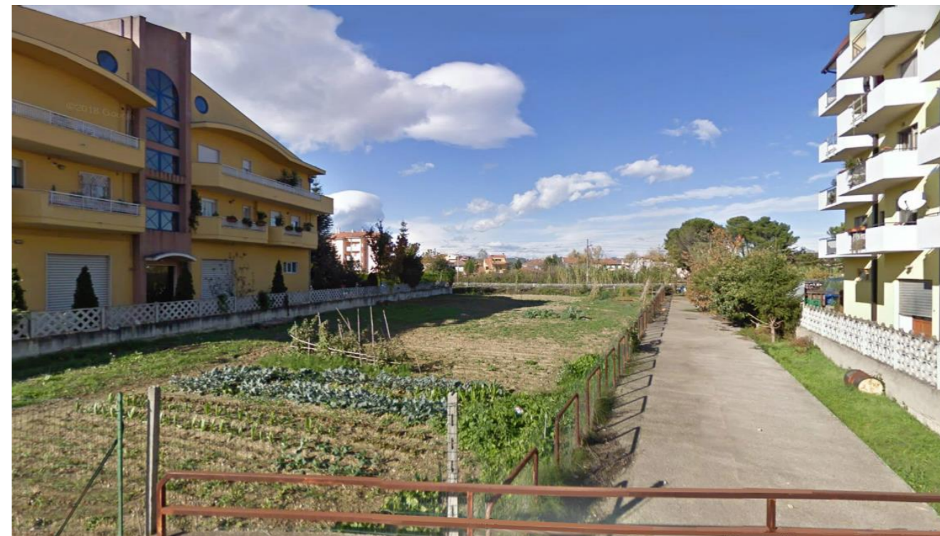
Figura 5-22 Ante operam. Sottopasso stradale dei Mille
