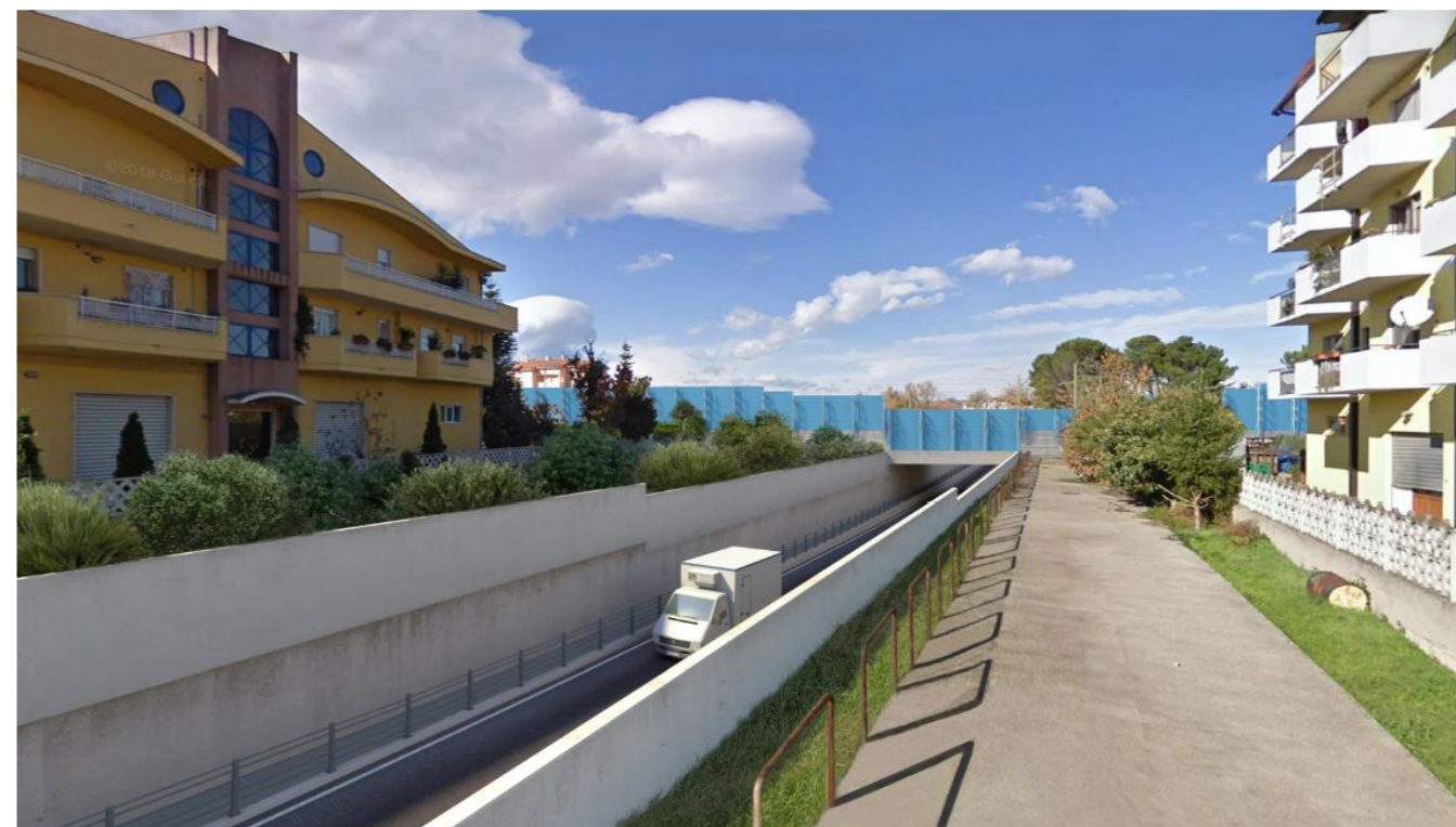
Figura 5-23 Ante operam. Sottopasso stradale dei Mille
