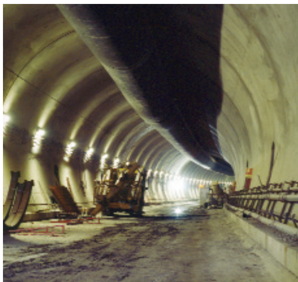
Tunnel di Vaglia - Firenze
