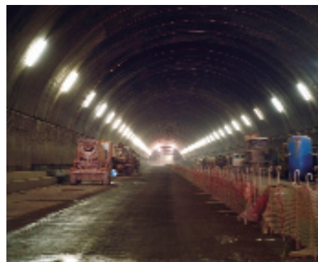
Tunnel di Firenzuola - Firenze
