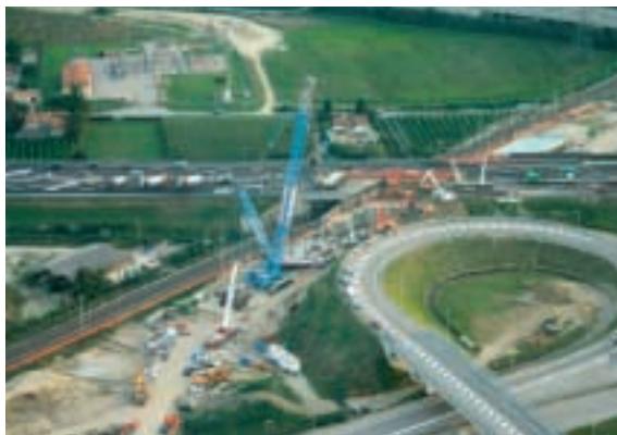
La nuova linea AV/AC Padova-Mestre: galleria artificiale di sottopassaggio dell'Autostrada A4 Brescia-Padova
