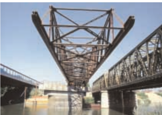
La nuova linea AV/AC Padova-Mestre: varo del ponte sul fiume Brenta
