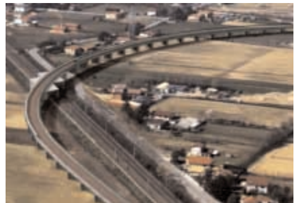
Lo "scavalco di Maerne": la linea per Trento sovrappassa la linea "storica" e la nuova linea AV/AC Padova-Mestre
