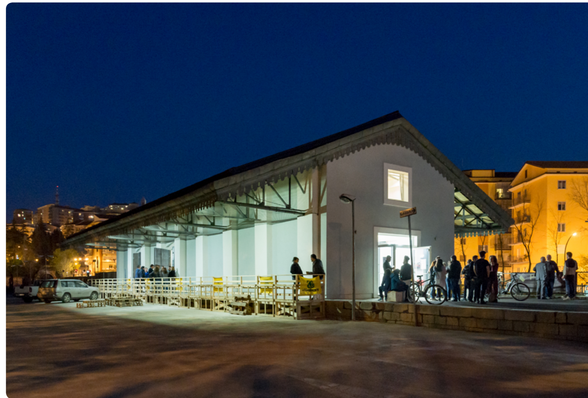
Magazzino merci, stazione di Potenza Superiore
