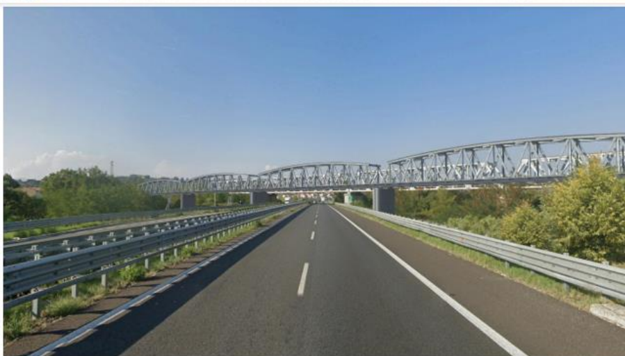
Viadotto VI01 Situazione Ante operam e post operam
