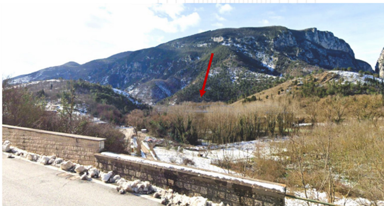
Figura 15 POST OPERAM - intervento VI01 - Viadotto, punto di vista strada statale 256 in frazione Gattuccio nel territorio comunale di Genga (AN)
