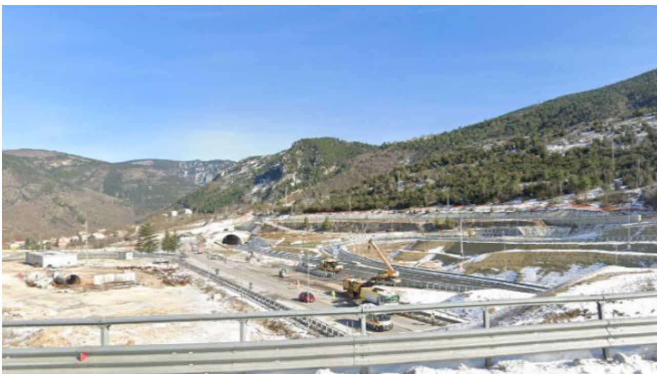
Figura 32 Area dello svincolo di Gattuccio lungo La SS256 e SS76 in fase di realizzazione (Genga)
