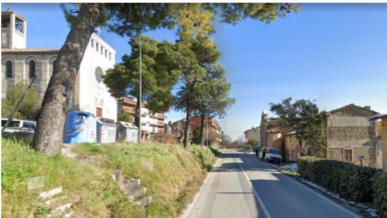
Figura 36 Tratto urbano della Sp14 in attraversamento di Serra S. Quirico Scalo
