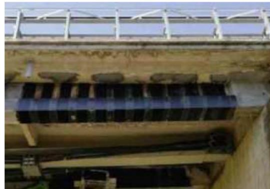
Foto 6.2 – Esempio rinforzo struttura con FRP
