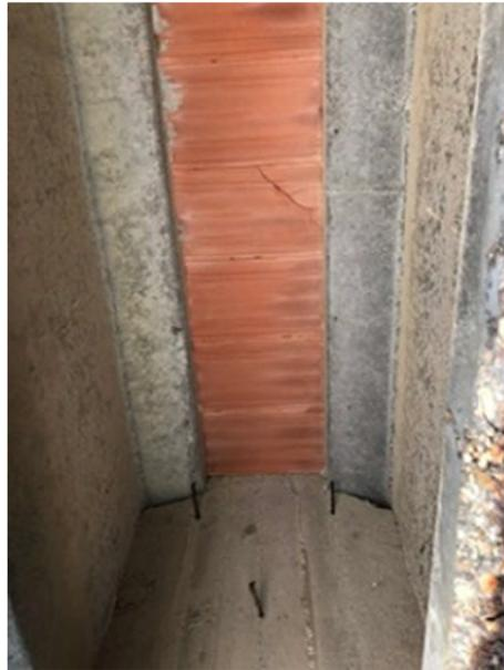
Figura 2.3 – Particolare soletta con elementi in laterizio
