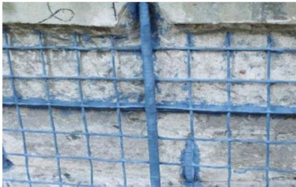
Foto 6.1 – Esempio trattamento ferri di armatura
