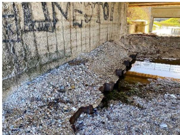
Foto 2.4 – Palancoolato a protezione della fondazione
