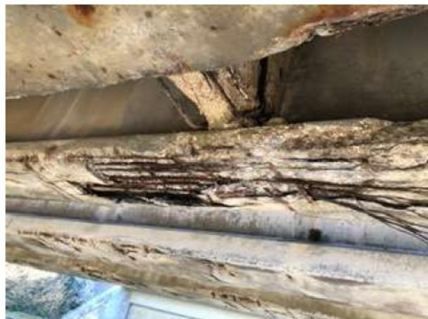
Foto 5.2 – Stato di conservazione delle travi in c.a.p.
