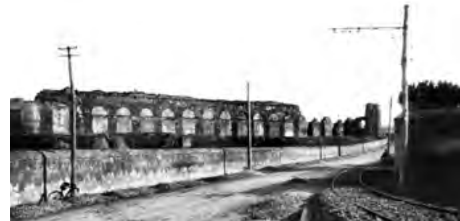
Thomas Ashby Arcate dell'Acquedotto Marcio e del tracciato della linea ferroviaria Roma Cassino Napoli, 1908 (Fondo Ashby British School at Rome)
