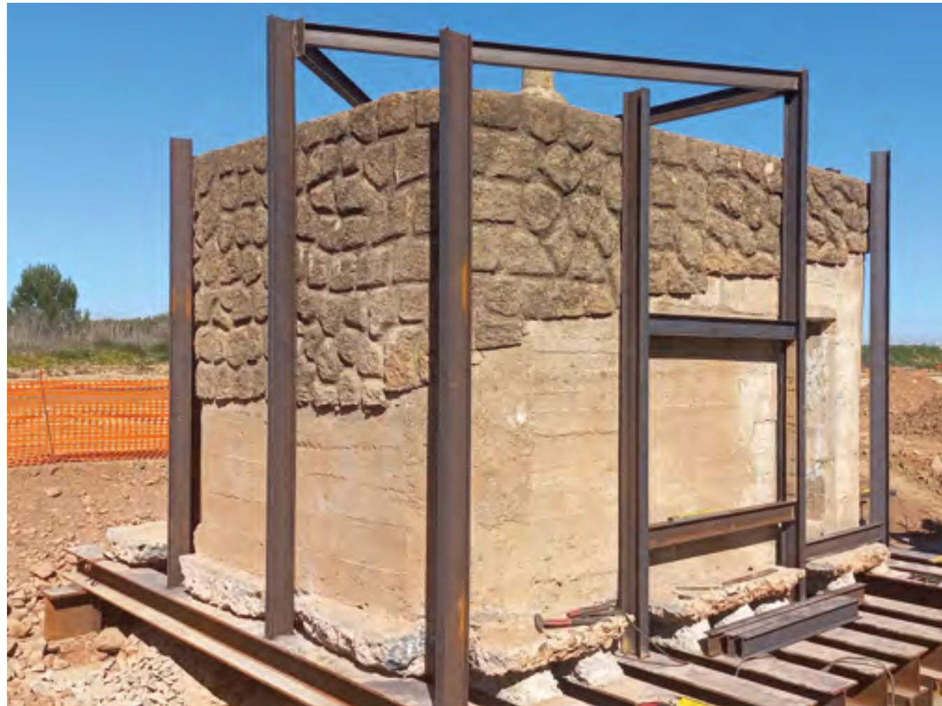
Struttura a gabbia utilizzata per la delocalizzazione (foto Ing. Michele Coghe)
