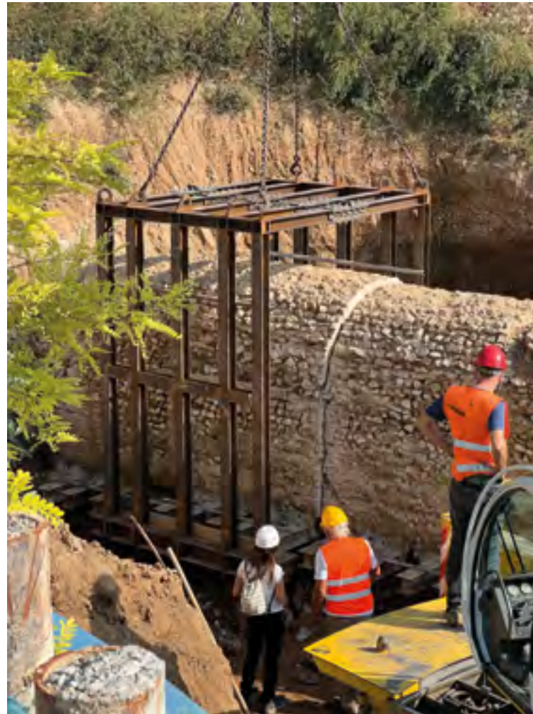
Smontaggio dell'acquedotto romano (foto Ing. Rosario Frosina)
